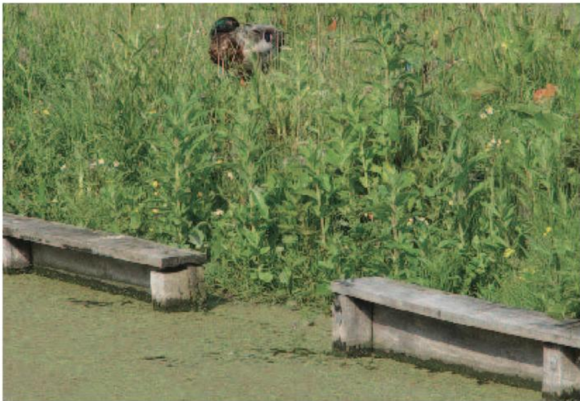
Foto: verwijdering van een klein deel van de bestaande beschoeiing en verlaging van de achterliggende berm zorgen voor een natuurlijker oevergradiënt. Bron: STOWA Handreiking Natuurlijke Oevers, p. 46.
