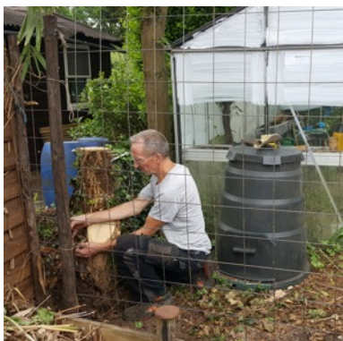
Tinus zet betongaas vast
